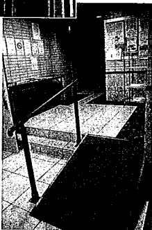
第1弾の「安寿の郷九大病院前」(福岡市東区、総戸数55戸)は、学生寮をコンバージョンしたものだ。空室率90%からわずか4ヵ月で満室になった(写真上右)。「九大病院前」の居室内。家具備品は、ほとんどが学生寮時代のもの。バリアフリー改修は、入居者が介護保険を利用して行なう(写真上左)。「九大病院前」の共用部分改修費は、車イス用スロープや廊下への手すり設置など、わずか20万円で済んだ(写真右)(写真提供:㈱三洋住宅)
